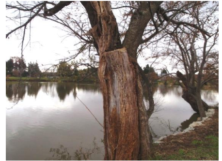
死んでいる樹脂(腐朽部)は、できるだけきれいに取り除く
